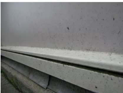
Huidige latten houden zand en vuil vast. Vochtbelasting.
