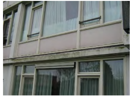
Op de pui aan de balkon zijde is het mogelijk neuslatten te plaatsen op de onderste dorpel, op de dorpel boven de pui vulling en op de kalven bij de kleine raampjes boven de draairamen.
