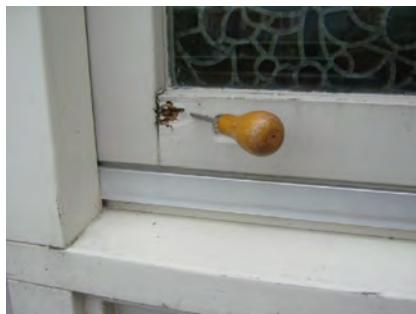
Bij veel aantasting vervangen. Scharniergrootte aanpassen aan nieuw kozijn.
