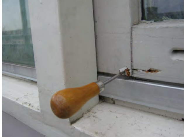
Draaiende delen kunnen over het algemeen beter vervangen worden. Bij voorkeur door meranti exemplaren. Scharnier aanpassen.
