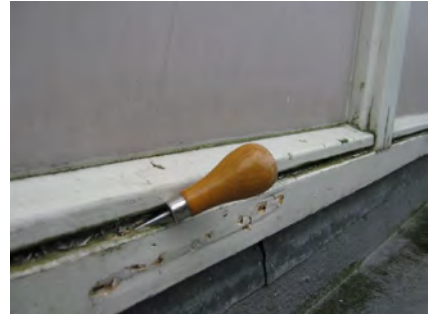
Onderdorpels bovenste verdieping vervangen, inclusief stijlansluiting.
